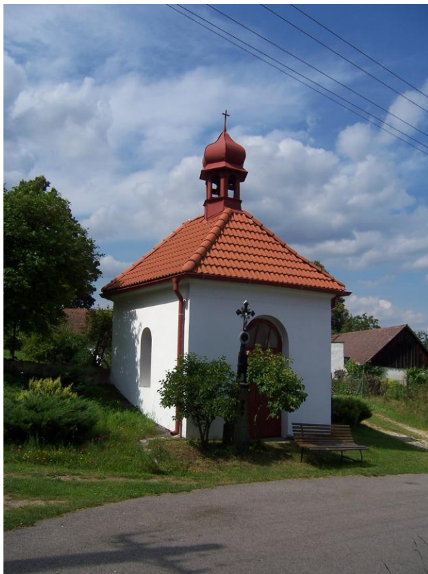
Rekonstrukce kapličky v Bukové, r. 2009
