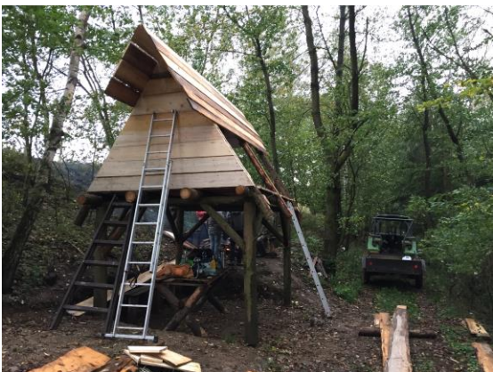
Ze stavby nové chaty na stejném místě
