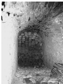
Zazděný vchod do bývalé štoly
