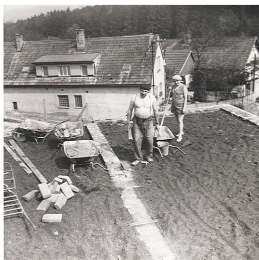
Ze stavby domu č.p. 27 na místě bývalého Doubkova statku
