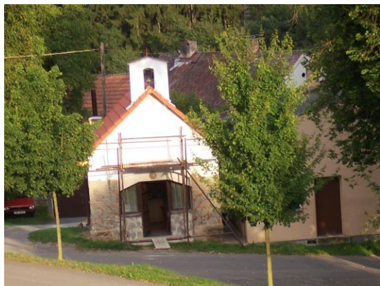
Rekonstrukce požární zbrojnice, r. 2005
